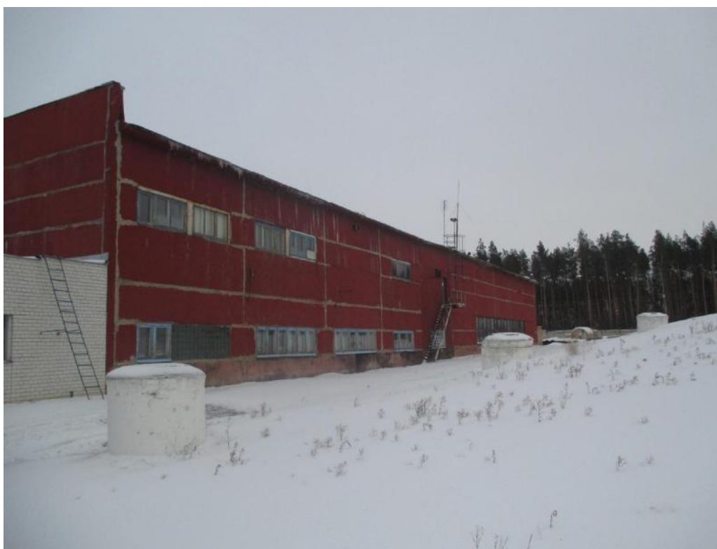
Общий вид комплекса станции 2-го подъема
